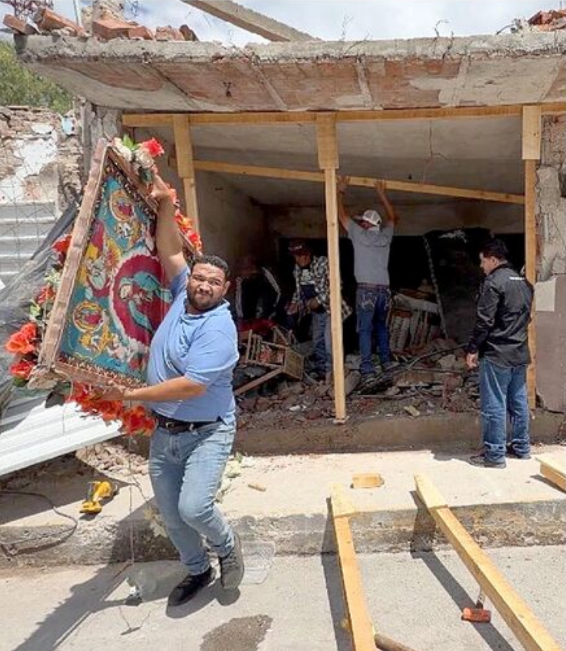
Colocan vecinos vigas de madera en una vivienda cercana a la explosión del autobomba.
