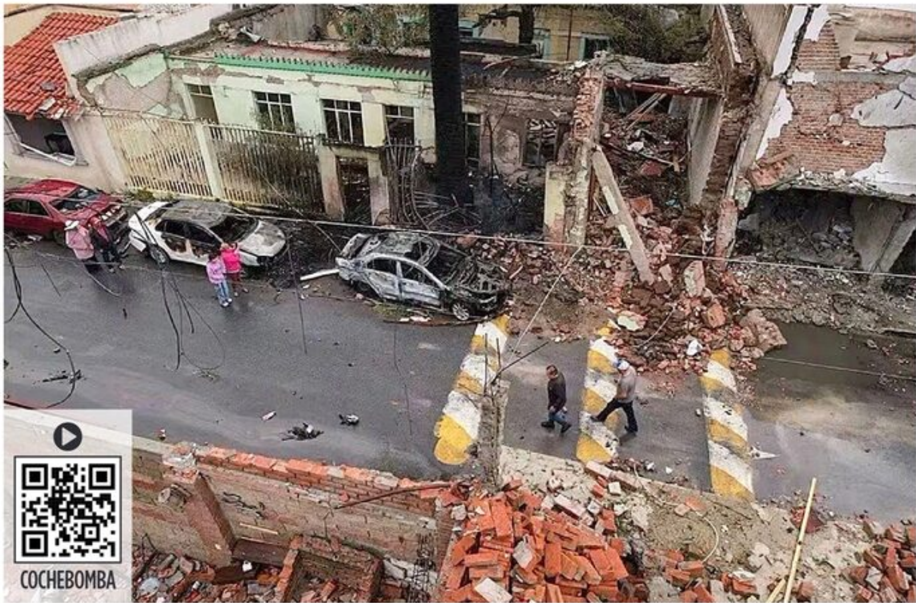
Escombros en fachadas, paredes derrivadas y autos quemados dejó la explosión el pasado domingo de un cochebomba frente a la Comisaría de Ojocaliente, Zacatecas.
