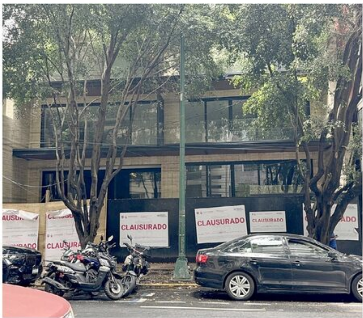
La Alcaldía colocó tapiales y sellos de clausura frente a la fachada del inmueble por violar la normatividad.
