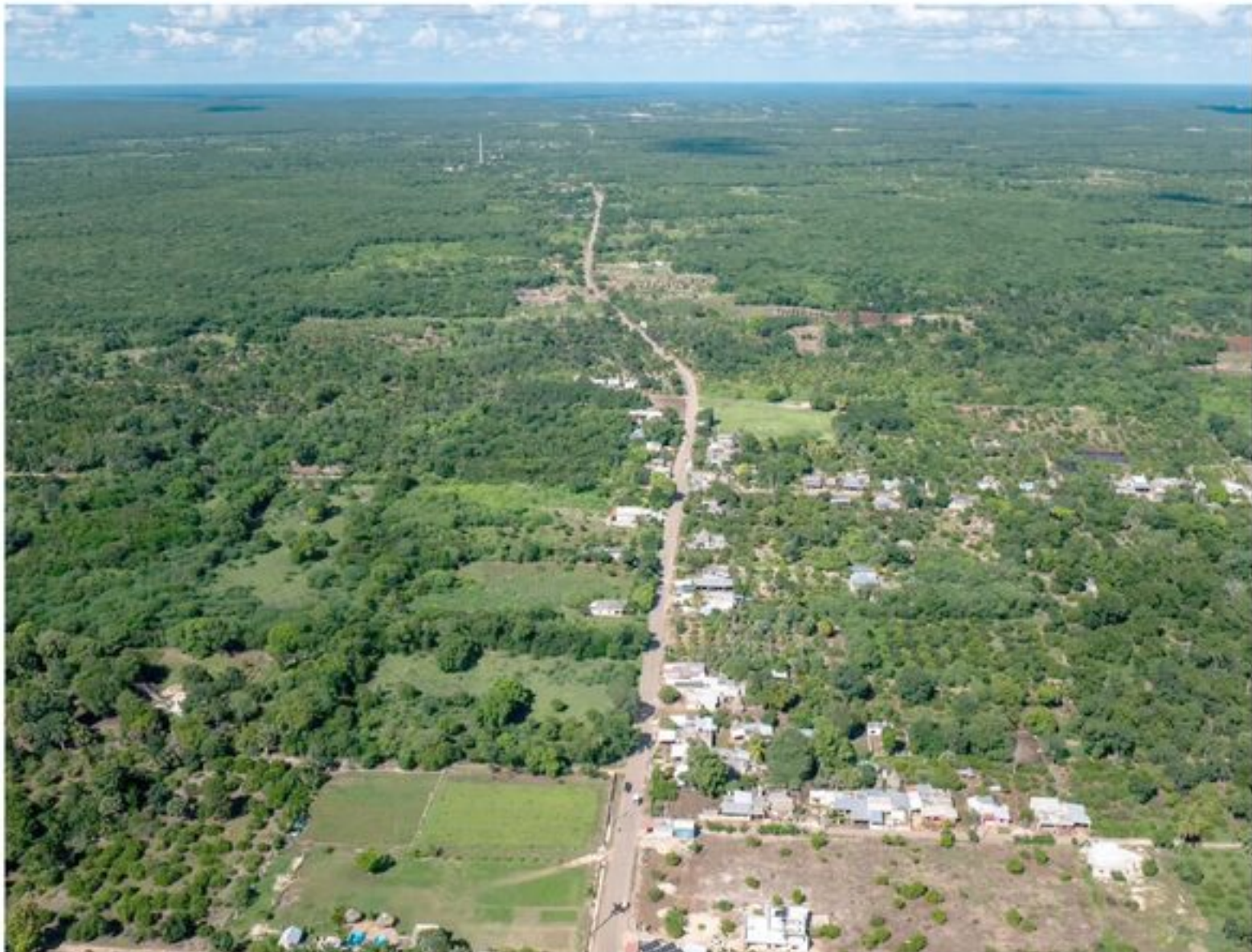
Con esta acción comenzó de igual forma la rehabilitación del tramo hacia el municipio de Oxkutzcab.
