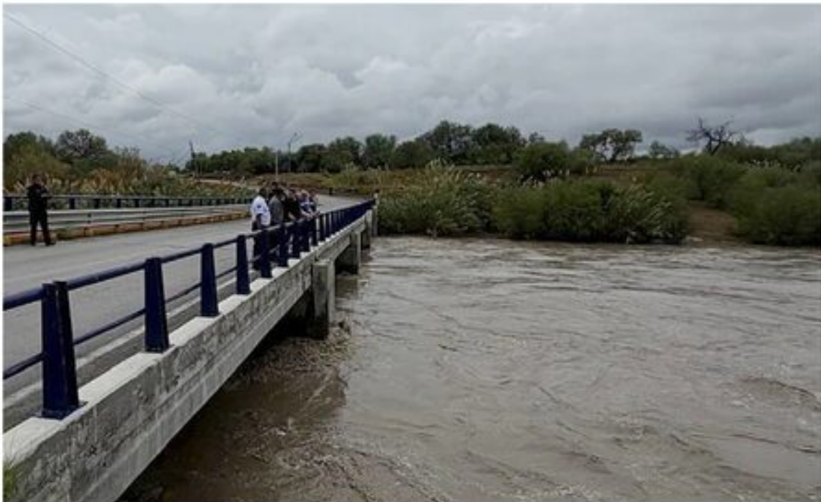
Autoridades cerraron de forma preventiva el puente de La Pedrera, en Los Ramones, ante el aumento del nivel del agua.
