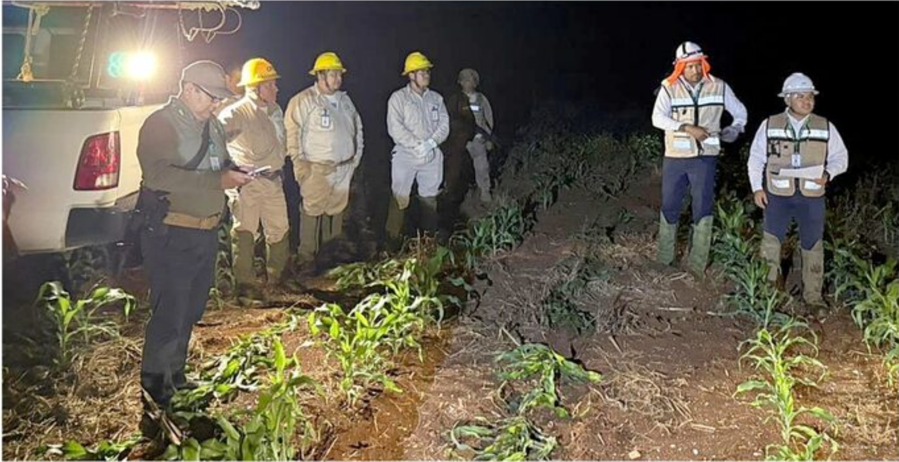
Trabajadores desplegados desde la noche del lunes para restablecer el servicio eléctrico.
