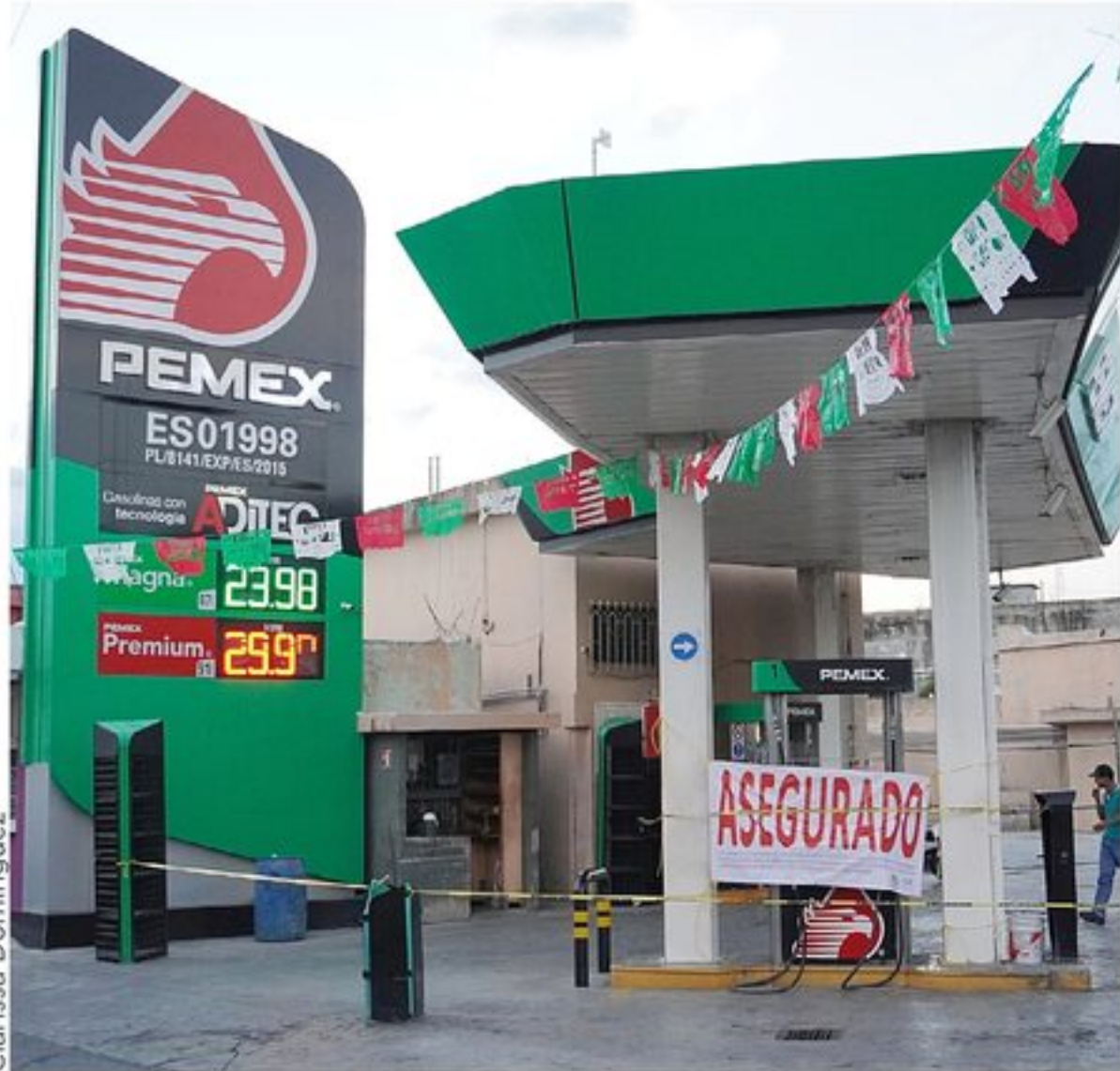
Inspectores colocaron sellos en gasolineras ubicadas en los municipios de Montemorelos y Allende, Nuevo León.
