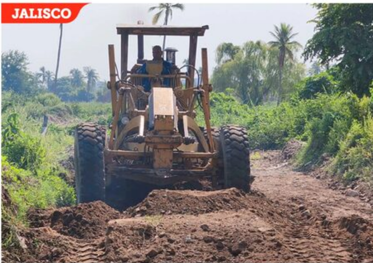
PC-Jalisco ■ Trabajadores de Protección Civil utilizan maquinaria para crear zanjas y así evitar el paso del agua en Puerto Vallarta.
