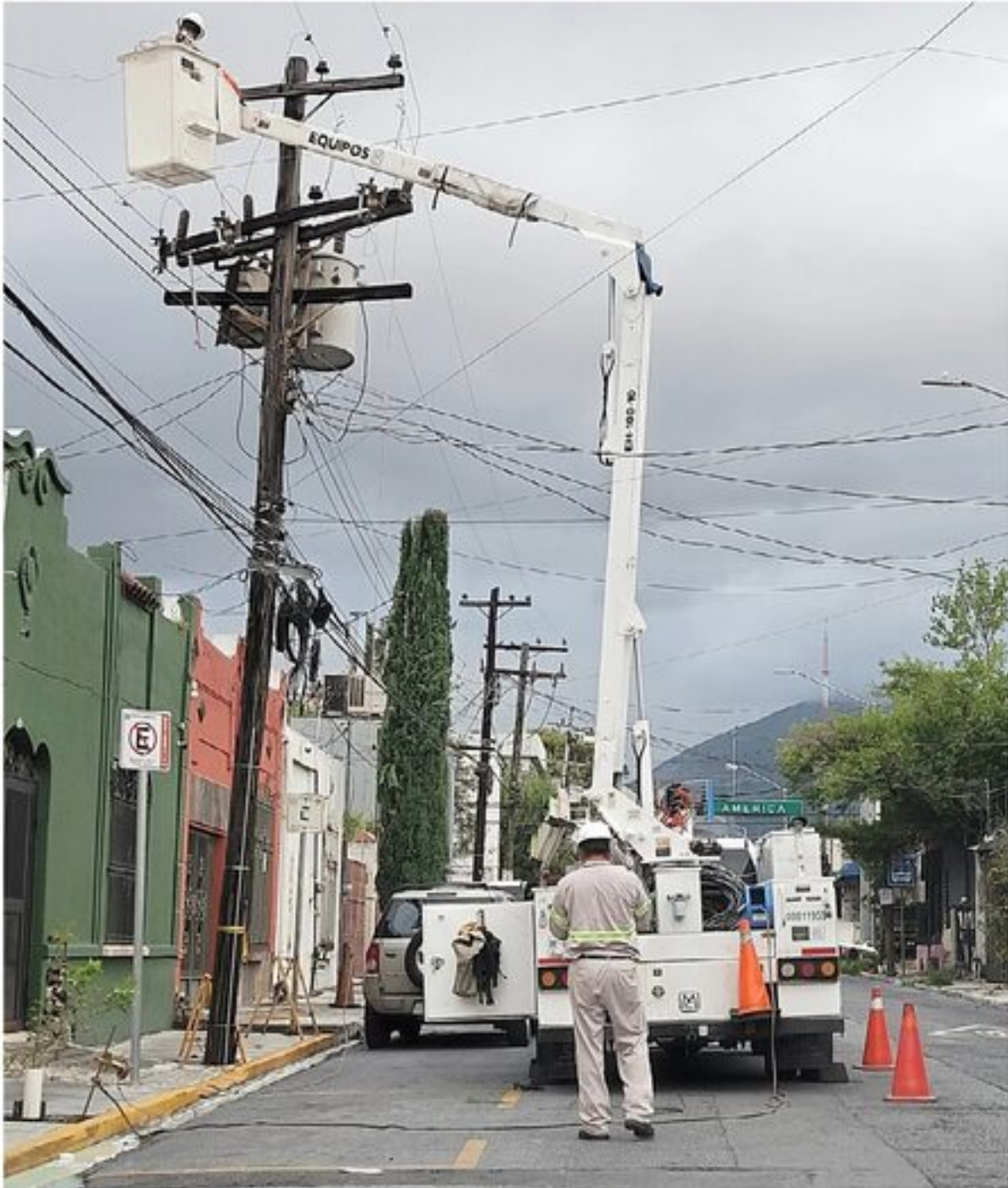
■ Cuadrillas de la CFE reparan cableado luego de que vecinos del Centro de Monterrey pasaron 8 horas sin luz.
